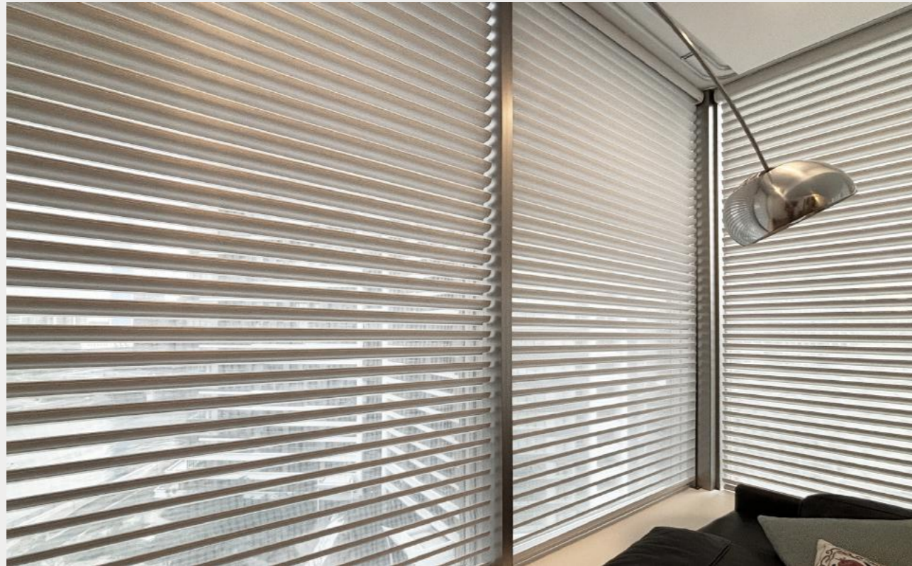
FA-190 スラット逆巻き仕様の施工事例です。
